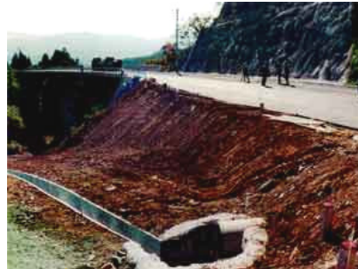
アルファグリーン工法 施工事例（宮崎県）
